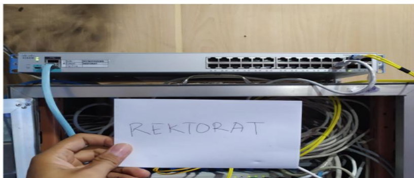
Gambar 13. Pemasangan 1 Unit Perangkat Cisco Gigabit Tipe C2960L di Rektorat.
