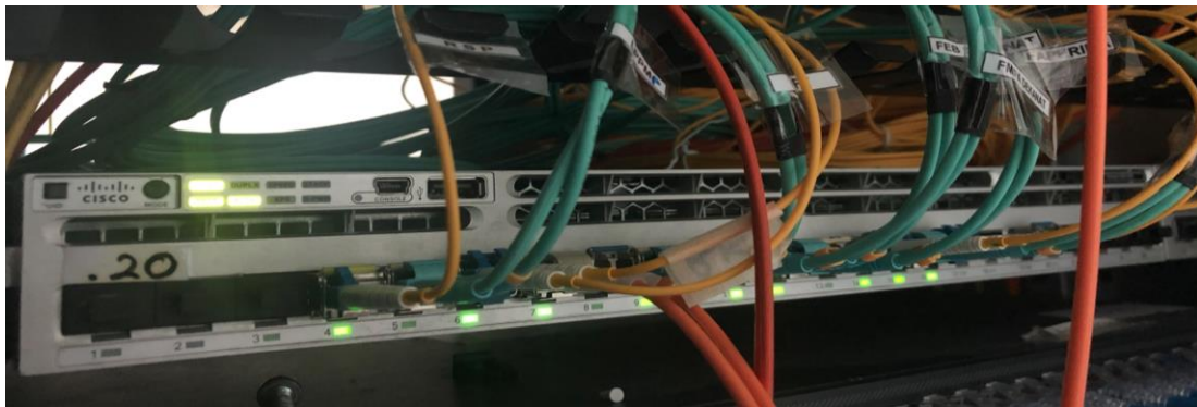
Gambar 11. Pemasangan 1 Unit perangkat Cisco Gigabit Tipe WS-C3850-24S di Server TIK
