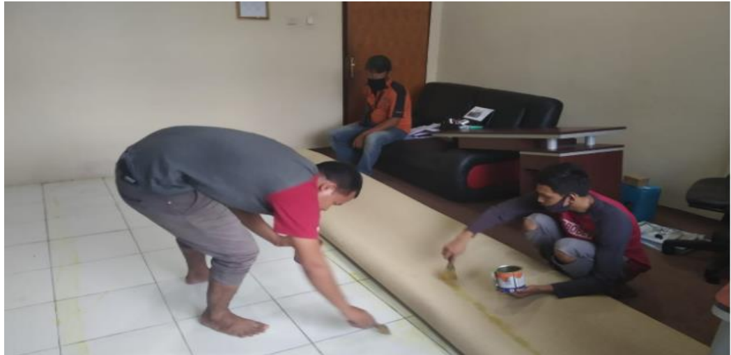
Gambar 4 : Renovasi Gedung dan Ruangan
